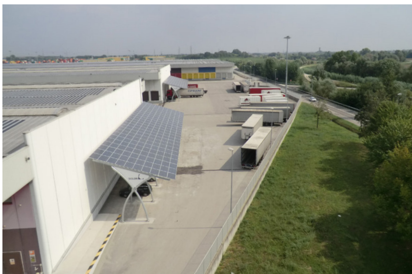
Figura 39: Impianto fotovoltaico su pensilina. Fonte: Interporto Padova.
