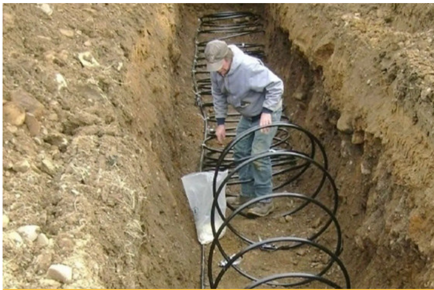
Figura 34: Scavo per la realizzazione dell'impianto. Fonte: geotermiaitalia.it
