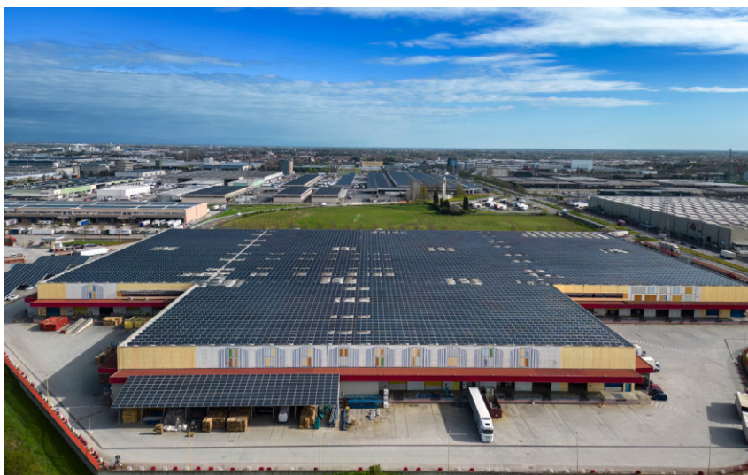
Figura 37: Impianto fotovoltaico sulle coperture dei magazzini e su pensilina. Fonte: Interporto Padova.
