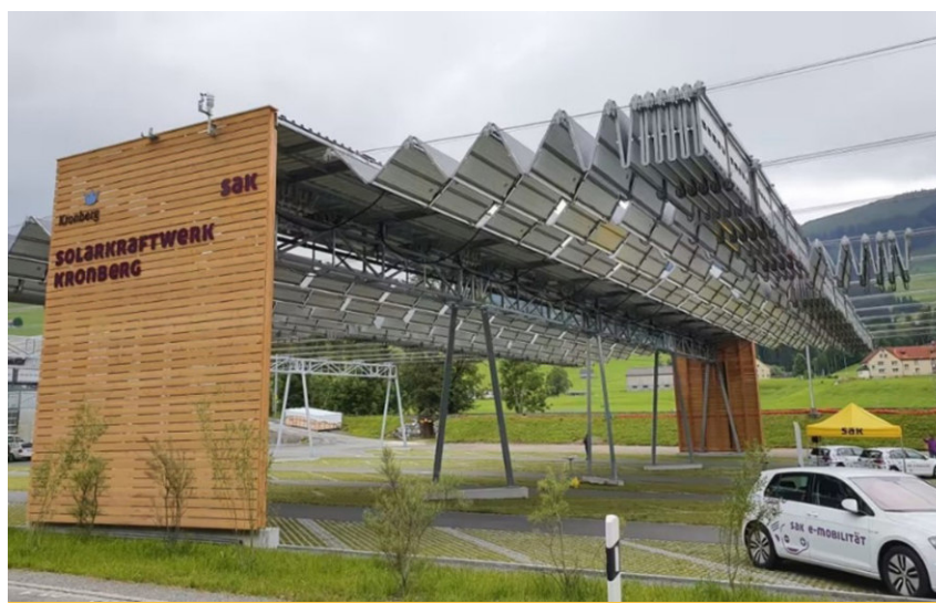
Figura 30: Pensilina fotovoltaica della funivia Jakobsbad-Kronberg. Fonte: svizzeraenergia.ch.
