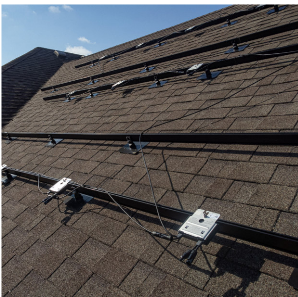
Figura 6: Ottimizzatore di potenza.
