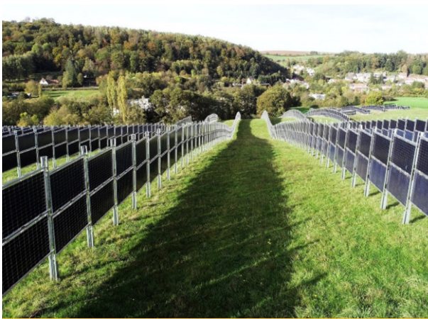
Figura 18: Impianto a pareti verticali. Fonte: Rinnovabili.it
