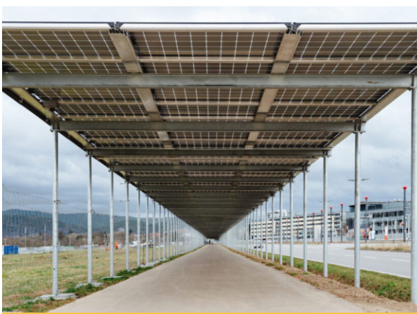
Figura 19: Pensilina fotovoltaica su pista ciclabile. Fonte: Futuro Prossimo
