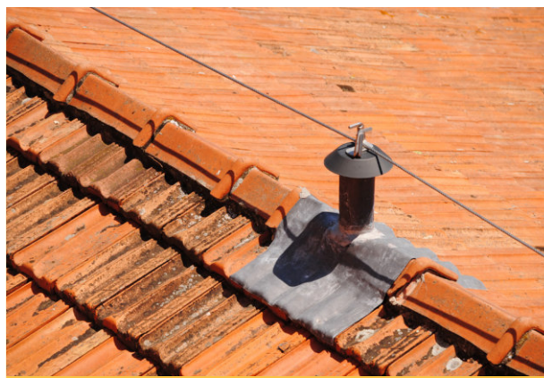
Figura 4: Linea vita su tetto di edificio residenziale Fonte: Immagine acquisita con licenza, Adobe Stock.
