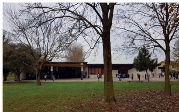
Figura 2 - La scuola esistente da sud
